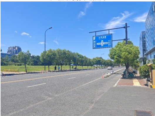
厂区南侧道路
