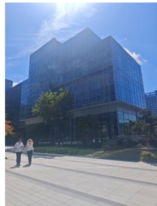
厂区西侧实地照片
