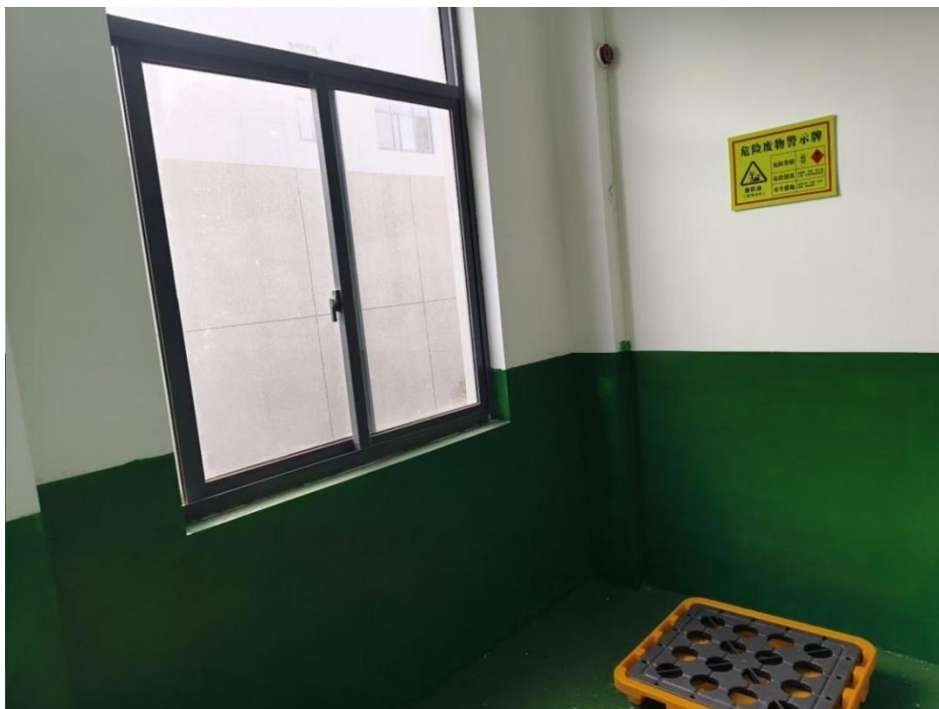
危废仓库内部
