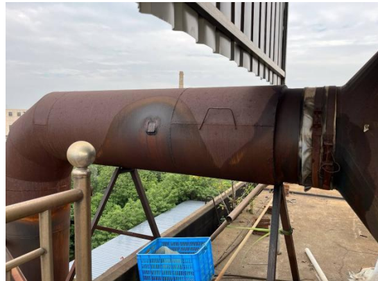
DA001 废气采样口-进口
