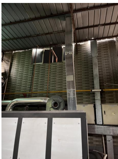
DA002 废气采样口-进口
