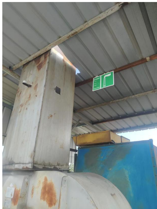
DA002 废气采样口-出口
