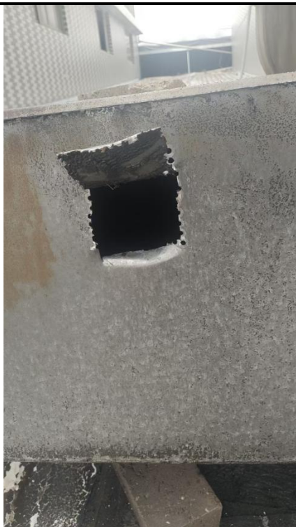
DA002 废气采样口-进口
