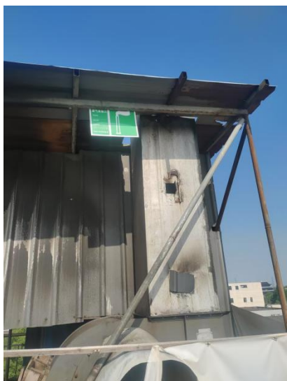
DA001 废气采样口-出口
