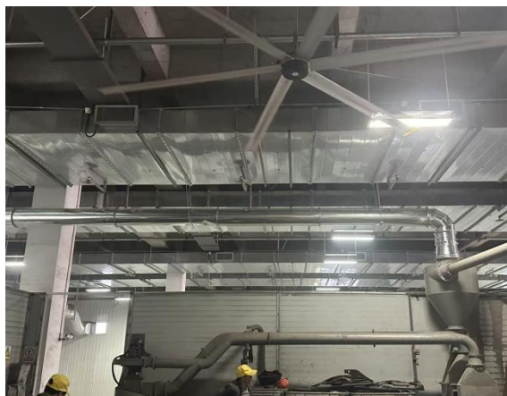
破碎废气收集设施
