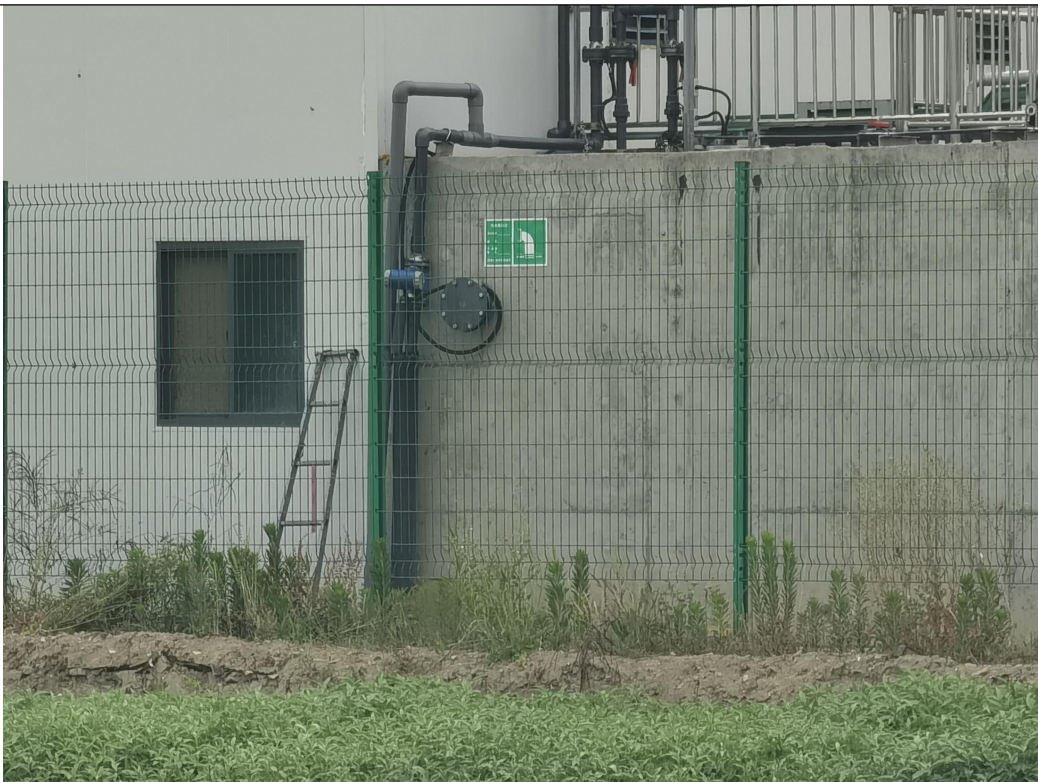
综合废水排放口
