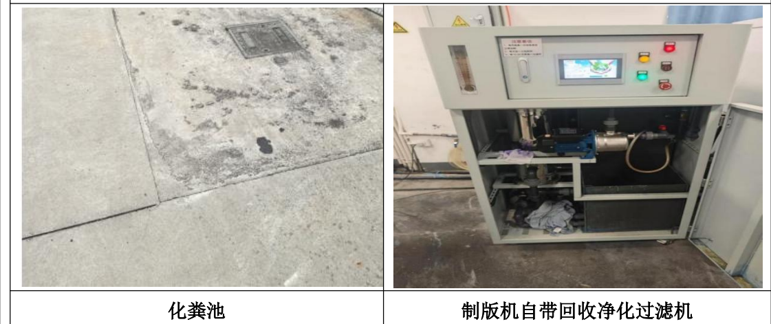
图 3-1 废水处理设施及排放口
