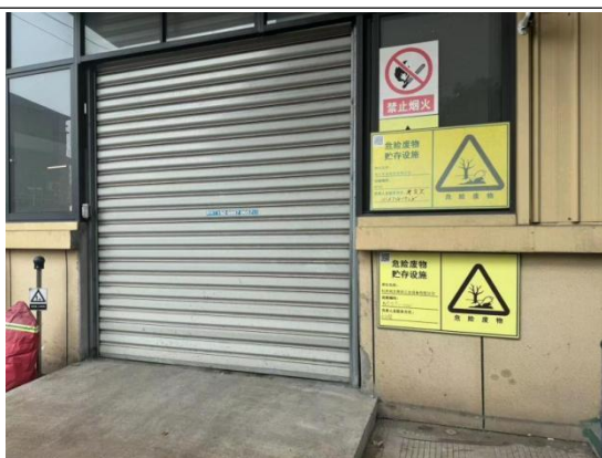
东风村厂区危废仓库外部
