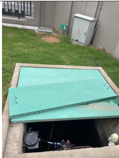
奉口村厂区总排口
