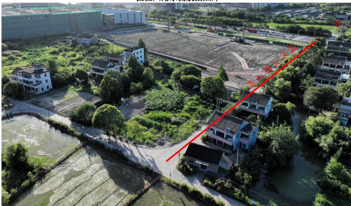
园区六路西侧航拍照片
