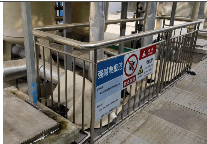
现有污水站浓碱废水收集池
