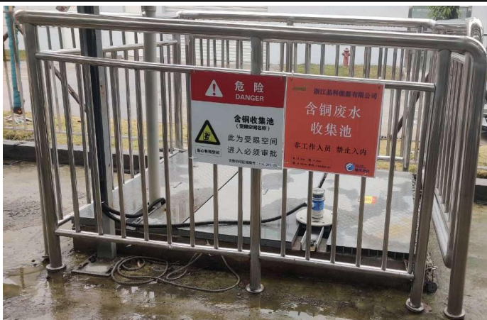
新建污水站含铜废水收集池
