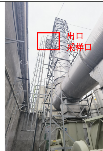
丝网印刷、封边废气 DA001 排放口
