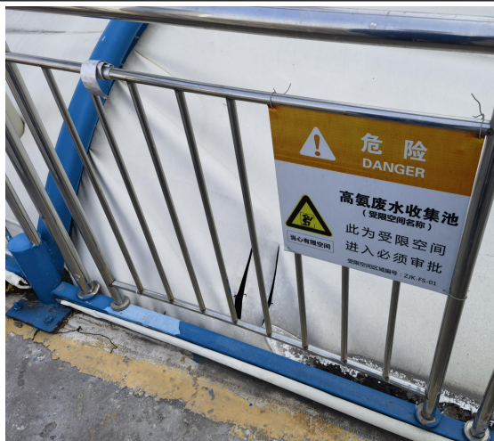
现有污水站高氨废水收集池
