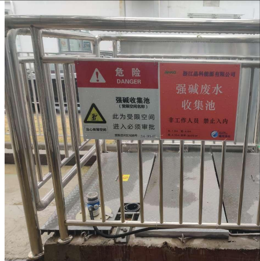
新建污水站刻蚀废水收集池
