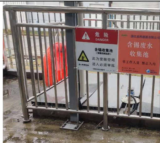
新建污水站含锡废水收集池
