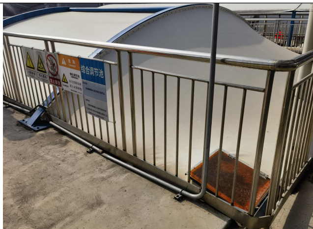
现有污水站含氟废水调节池
