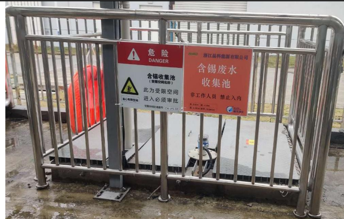
新建污水站含锡废水收集池
