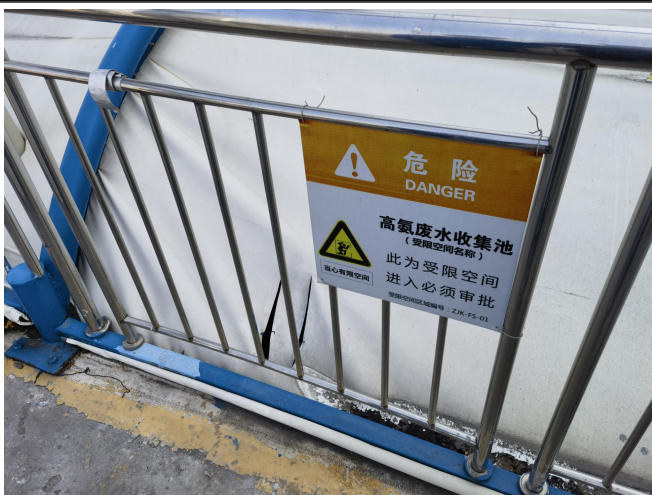
现有污水站高氨废水收集池
