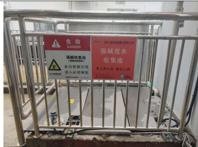
新建污水站刻蚀废水收集池
