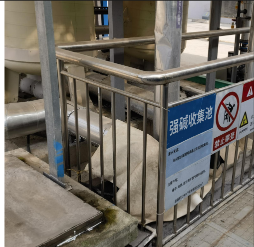
现有污水站浓碱废水收集池
