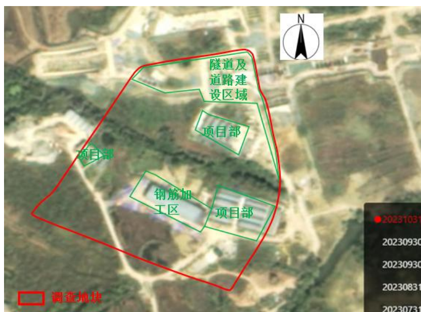
图 3-14 项目部及道路、隧道建设区域
