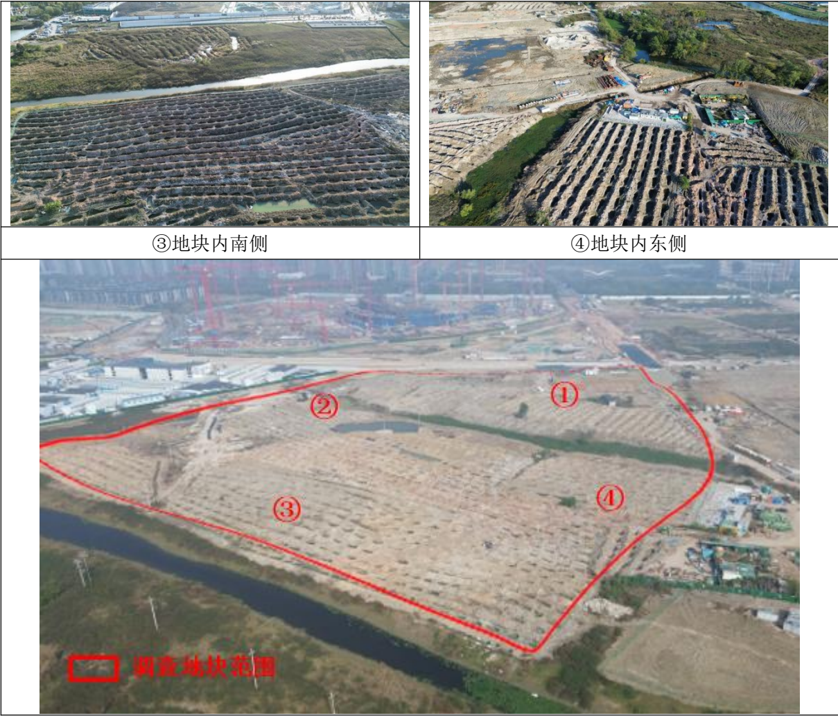
图 3-11 地块内现状照片（踏勘期间）
