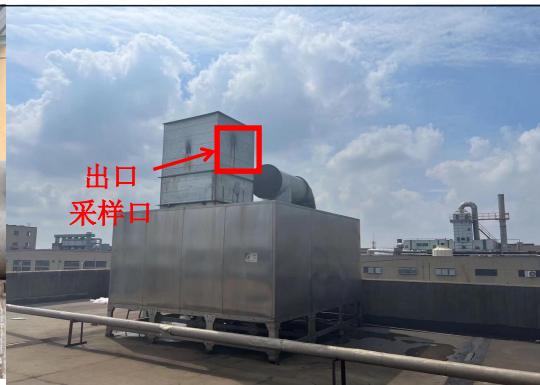
压延线废气收集
