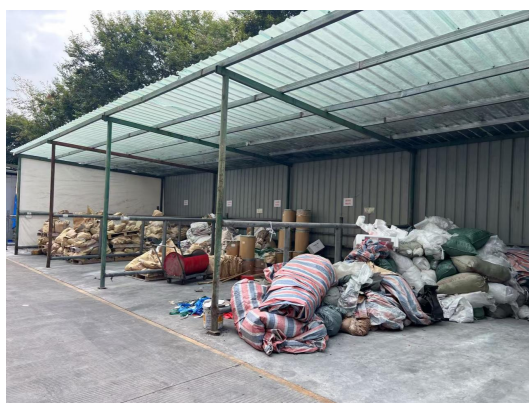
一般工业固废仓库
