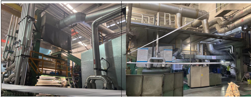
压延线废气收集
