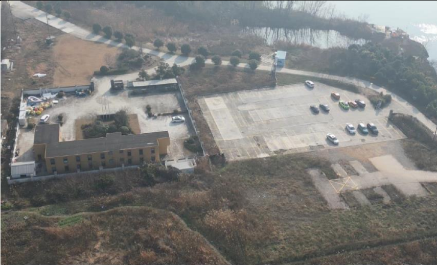
图3-29 现存原花漾年华项目项目部
