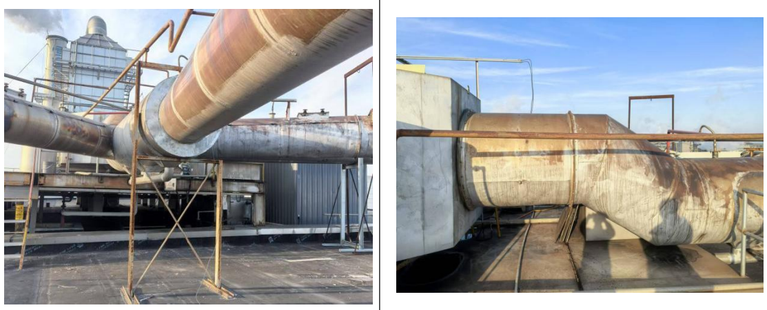
定型废气进口收集管线图
