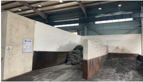
东风村厂区一般固废仓库
