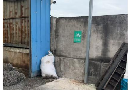
东塘村厂区一般固废仓库
