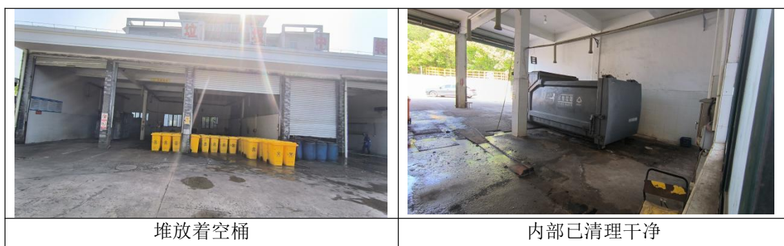
图 3-13 2024 年 2 月环卫站现场踏勘照片
