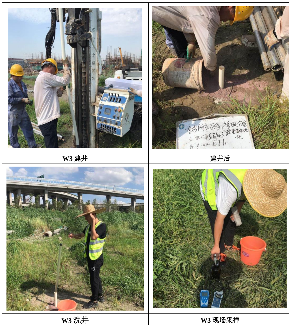
图5-6 部分地下水建井、采样照片
