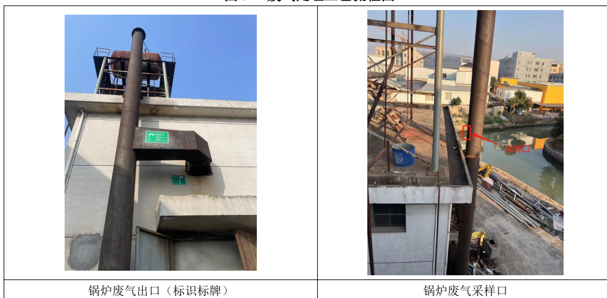
图 3-2 检测口（锅炉废气）
