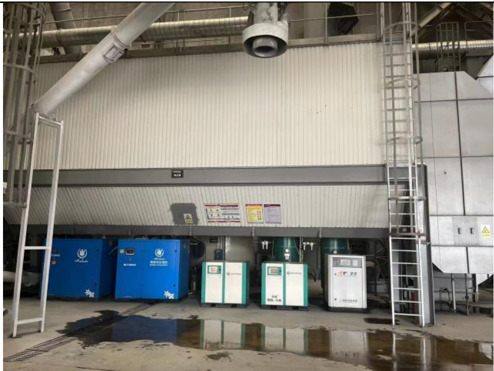
图 2-4 旋风+二级布袋除尘装置
