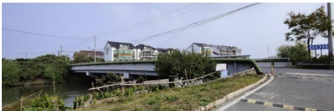
图 3-38 丁山河洋桥现状情况
