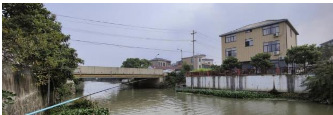
图 3-37 接坝桥现状情况
