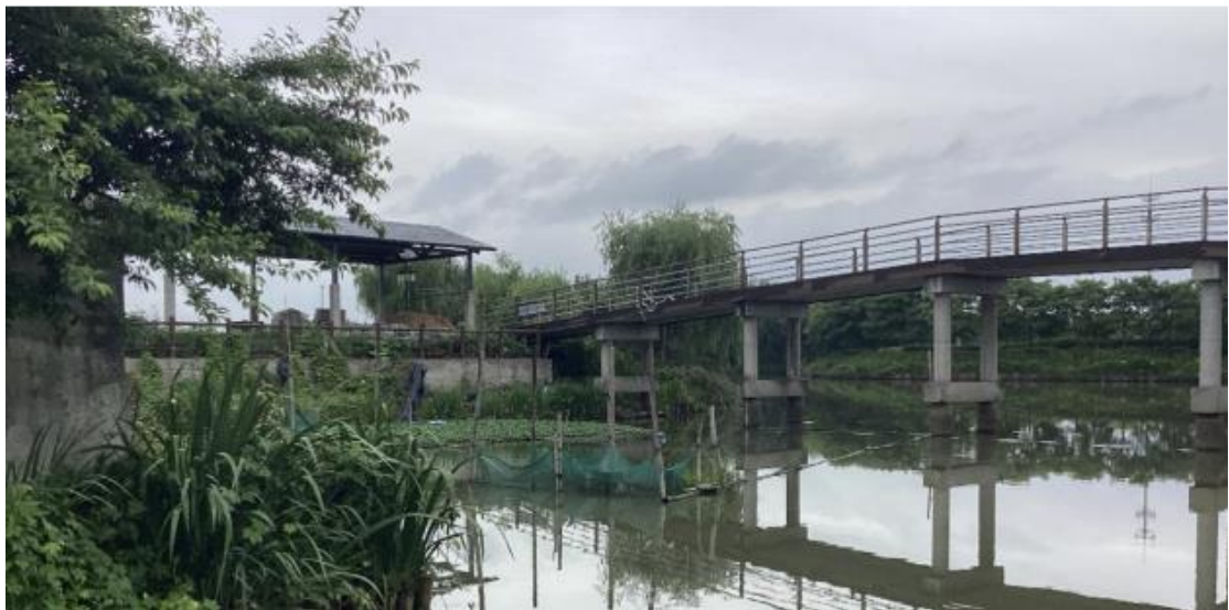
图 3-41 村道人行桥现状情况
