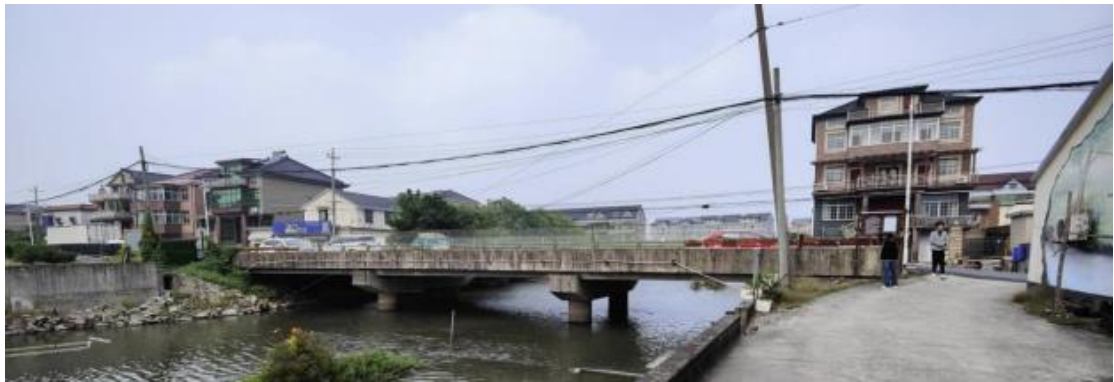
图 3-39 良田湾桥现状情况
