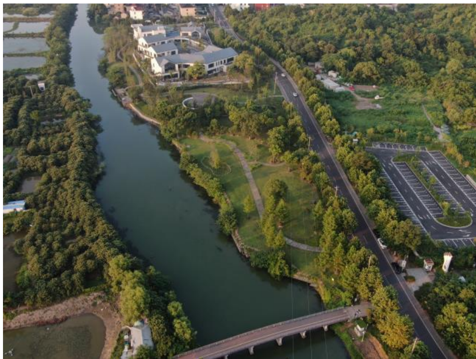
图 3-16 西入口充电点亲水平台现状
