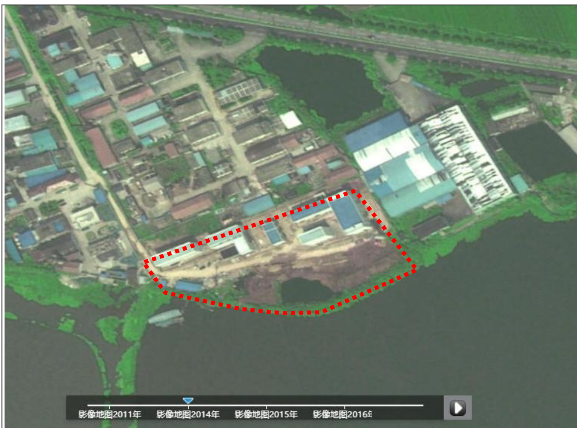
天地图-2014年影像图（企业红线内的土地上正在建设构筑物，地面未硬化；南侧为空地及水坑）
